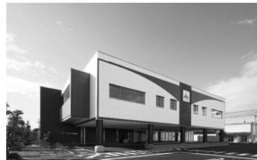
井村屋グループ本社屋
