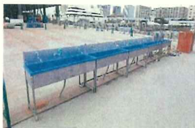
現場の手洗い場所の増設
